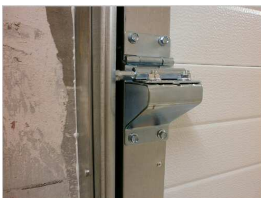
Detail spojení panelů
