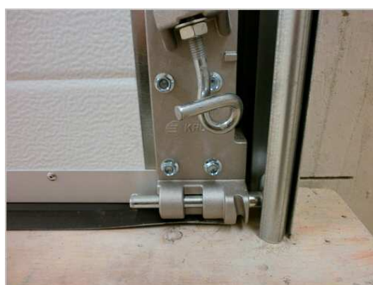
Detail vedení spodního panelu
